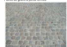
Pavés de granit à joints fermés
